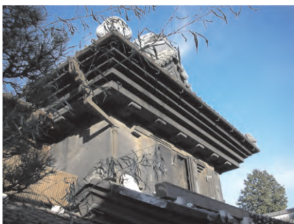
↑磚瓦、石材特色建築
