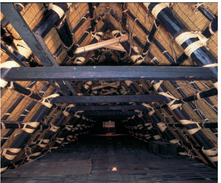
↓獨特的合掌造建築工法，不用一根釘子
